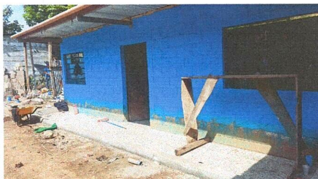
foto 2: Proceso de pintado de paredes, balcones y puerta de aula No. 2
