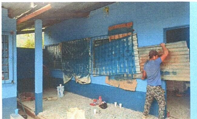
Foto1: Proceso de reparación de ventanas y balcones de aula No. 1
