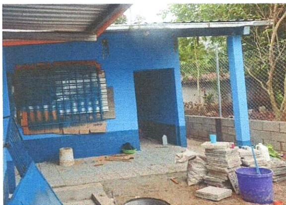
Foto 3: .Proceso de pintado en paredes, e instación balcones y de piso de granito en aula No. 1
