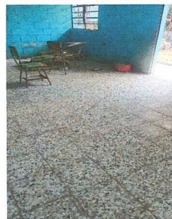
Foto 4: Instalación de piso de granito en aula No. 2
